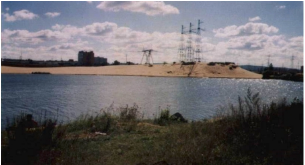
Рис.2. Вид на линию электропередач в районе оз. Пляжное
